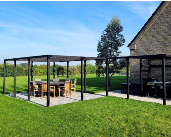
Terrassepergola bygget med Cubic-beslag
