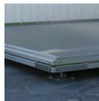
Højdejustering med justerbare fødder
