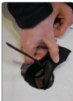
Pres underdelen sammen, og før den ind på bagsiden af undertaget.
